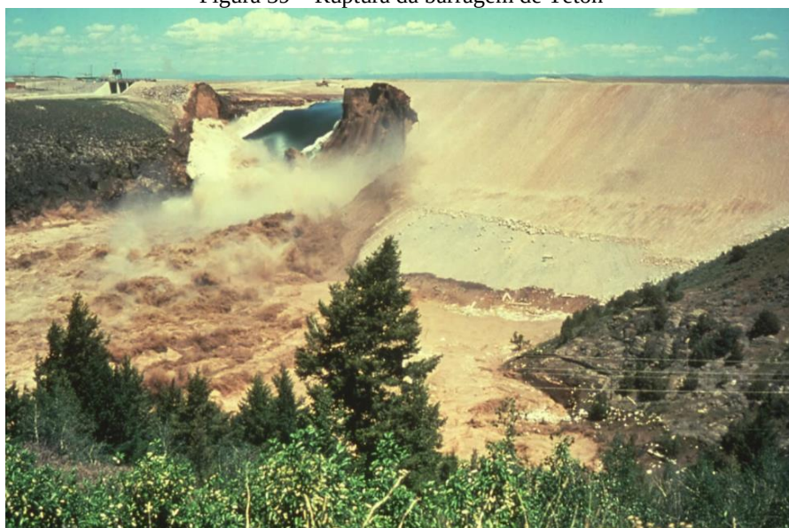
Figura 39 – Ruptura da barragem de Teton
