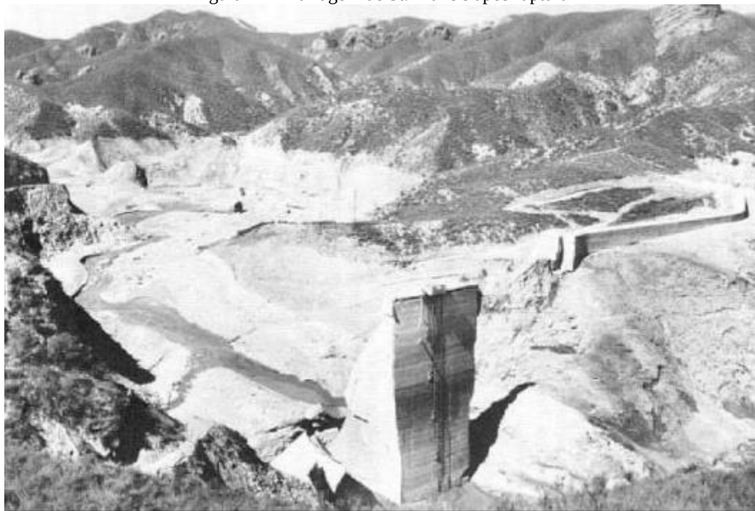
Figura 41 – Barragem de St. Francis após ruptura
