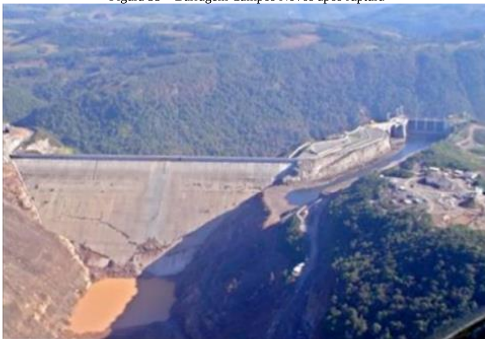
Figura 35 – Barragem Campos Novos após ruptura
