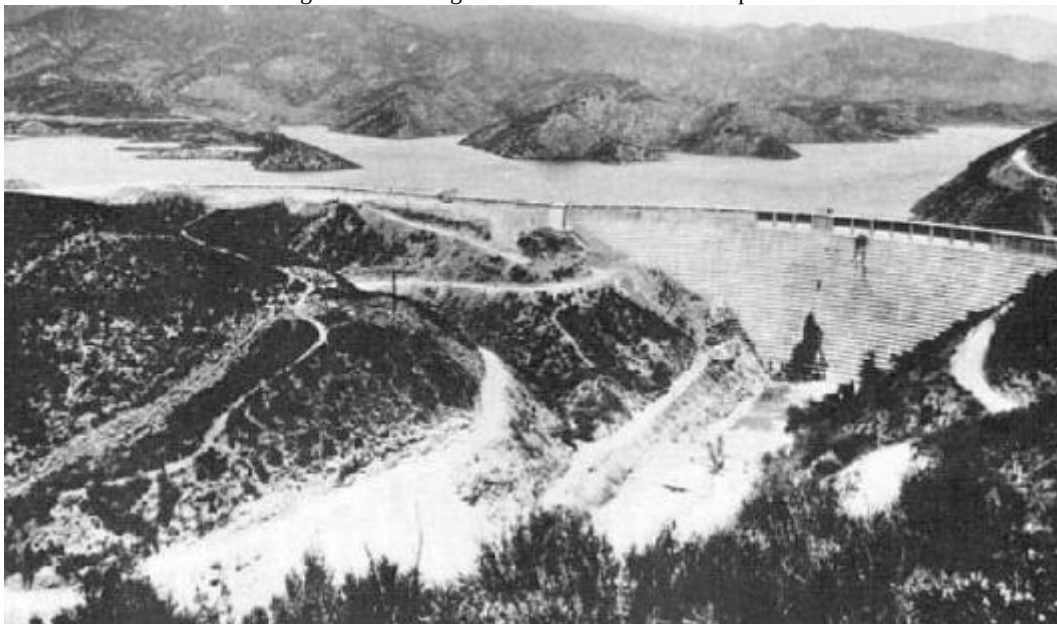
Figura 40 – Barragem de St. Francis antes da ruptura
